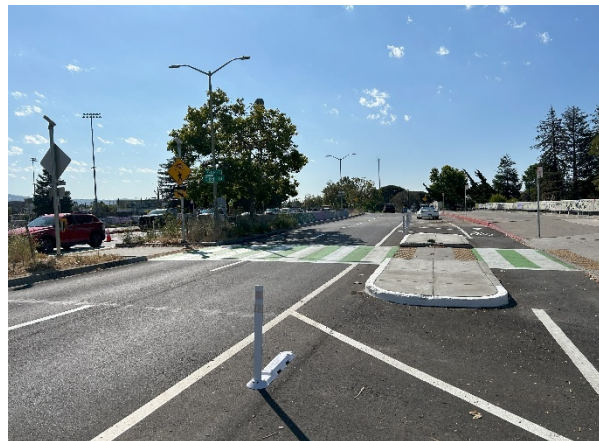
Lối qua đường được kẻ lại giữa dãy nhà với đảo bê tông
