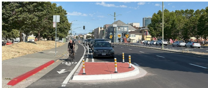
Đảo bê tông mới và làn xe đạp được làn đổ xe bảo vệ trên 7th St
