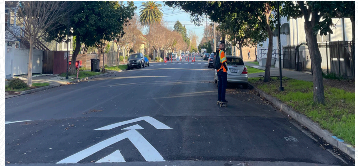
西屋崙 8th Street 的減速丘。
