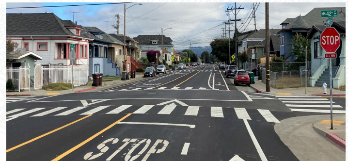
Intersección elevada en West St & 42nd St.
