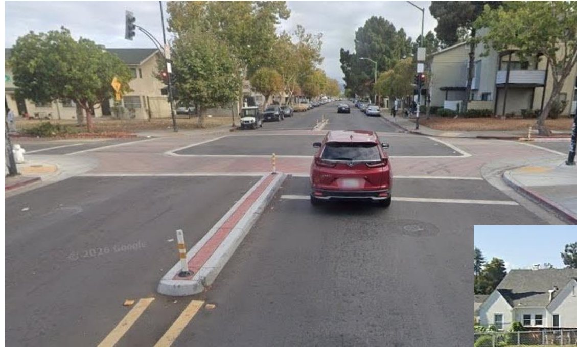
車道間的混凝土分隔帶
